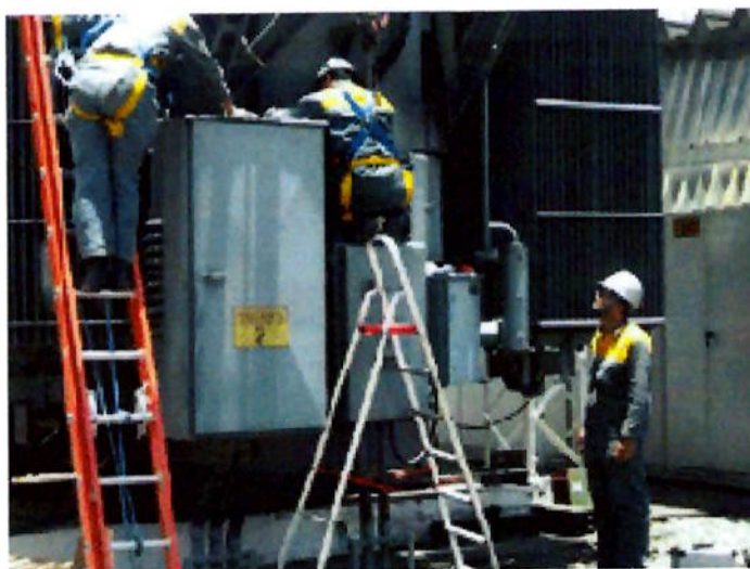
Figura 18 – Manutenção em Transformadores. Fonte: www.efacecenergy.com.br
