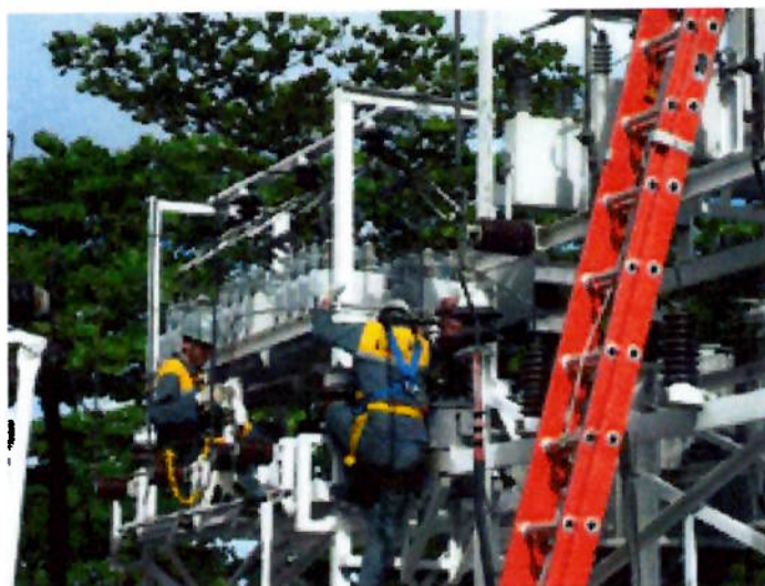
Figura 19 – Manutenção em Banco de Capacitores. Fonte: www.efacecenergy.com.br
