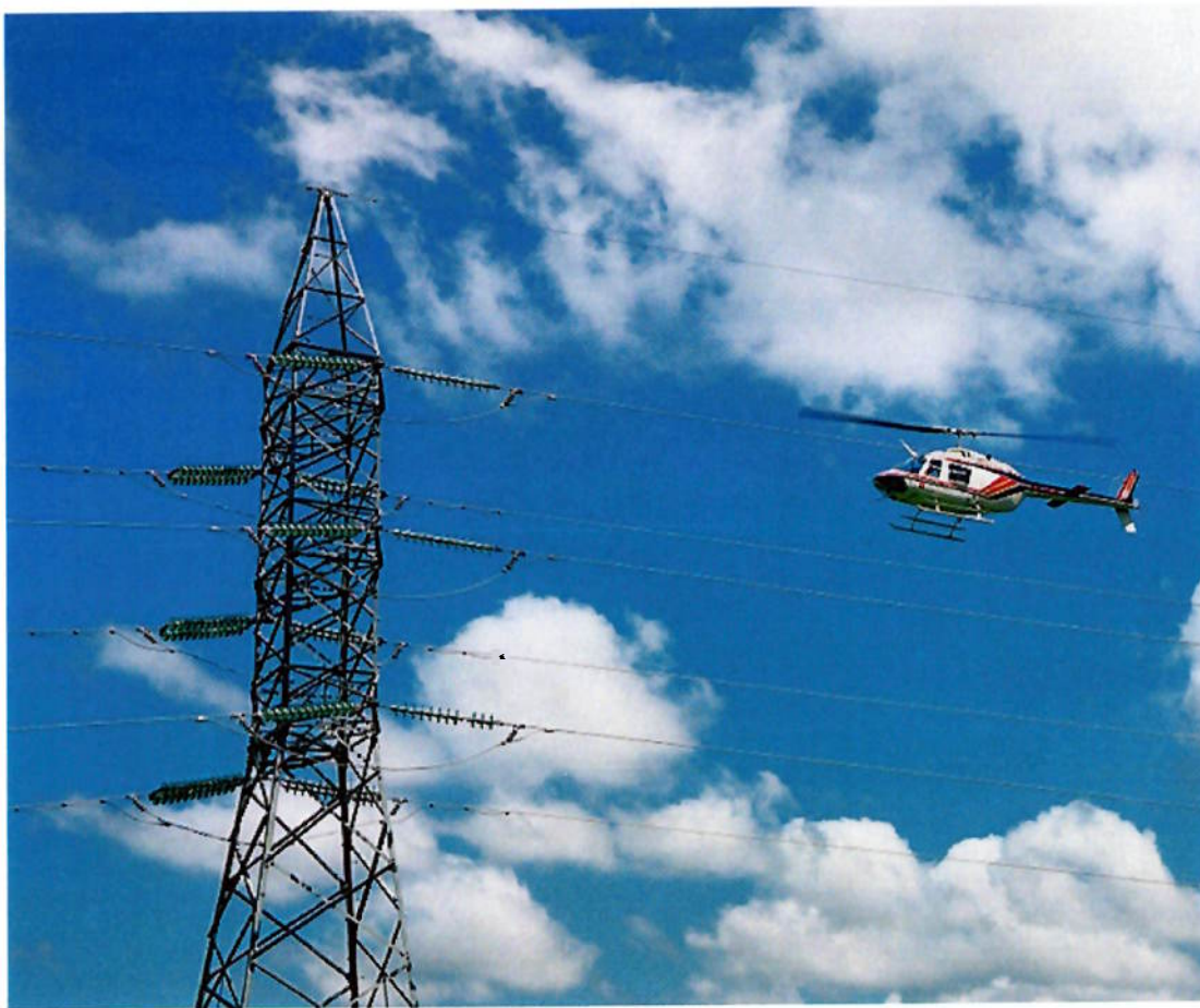
Figura 7 – Inspeção aérea com helicóptero. Fonte: www.cteep.com.br
